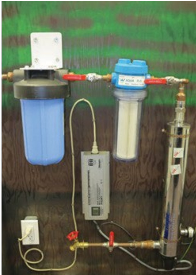
Exemple de filtre et de système de désinfection par rayonnement ultraviolet
