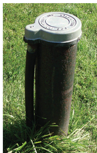
Puits foré bien construit. Le bouchon du puits doit être réfectionné pour améliorer la sécurité du puits (bouchon représenté à gauche).
