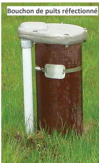
Puits foré bien construit. Le bouchon du puits doit être réfectionné pour améliorer la sécurité du puits (bouchon représenté à gauche).
