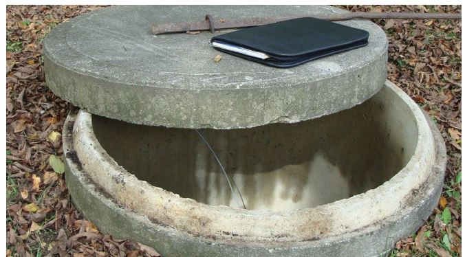
Il faut assurer l'entretien des puits à intervalles réguliers. Les puits doivent être faciles d'accès et être entretenus, réparés, réfectionnés et mis hors service au besoin, en plus d'être soumis à des essais à intervalles réguliers. Il est utile de tenir des relevés de ce qui a été fait (par qui, quand, pourquoi et comment).
